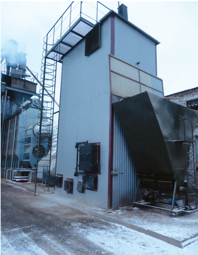
Рисунок 2 – Теплогенератор гібридного типу в складі своєї конструкції має продуктивні топку та теплообмінник
