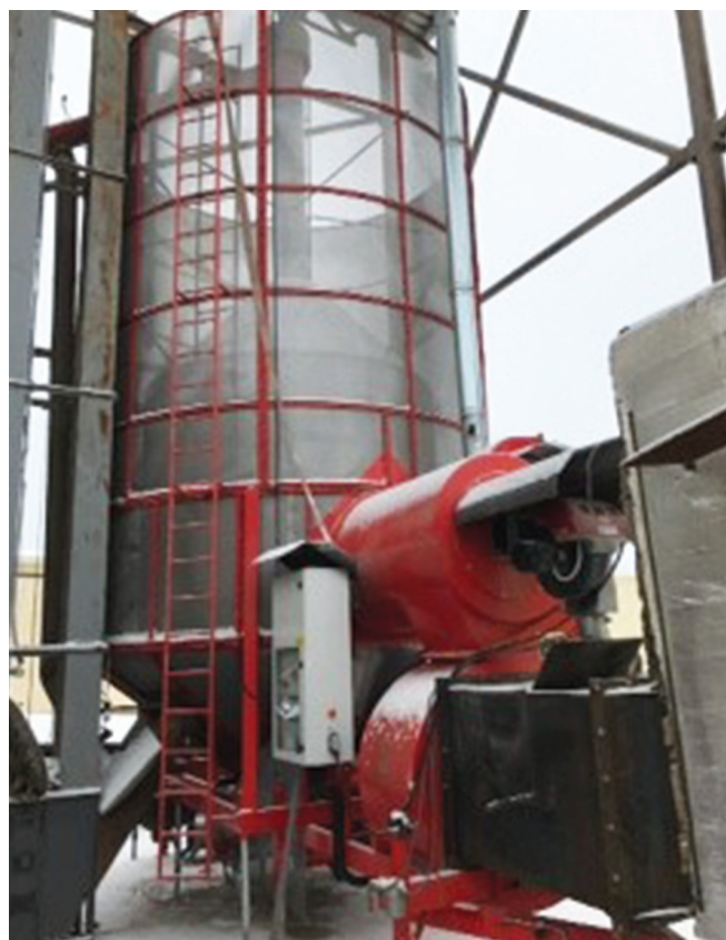
Рисунок 4 – Теплогенератор розміщено безпосередньо біля мобільної сушарки (загальний вигляд із сушаркою)
