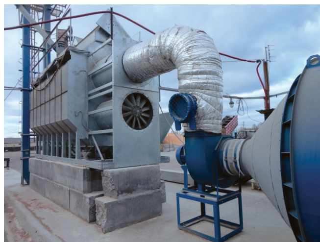
Рисунок 5 – Теплозабезпечення зерносушарки модульного типу (на передньому плані фото, справа, теплообмінник комплексу)
