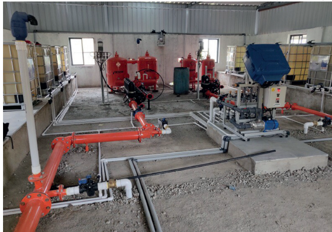
Рисунок 5 – Автоматизована система управління обладнанням підземного крапельного зрошення компанії «Netafim», Ізраїль
