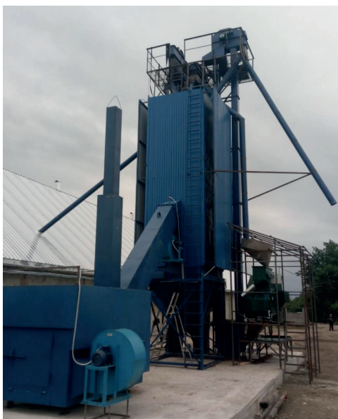
Рисунок 2 – Загальний вигляд зерносушарки з боку теплогенератора
